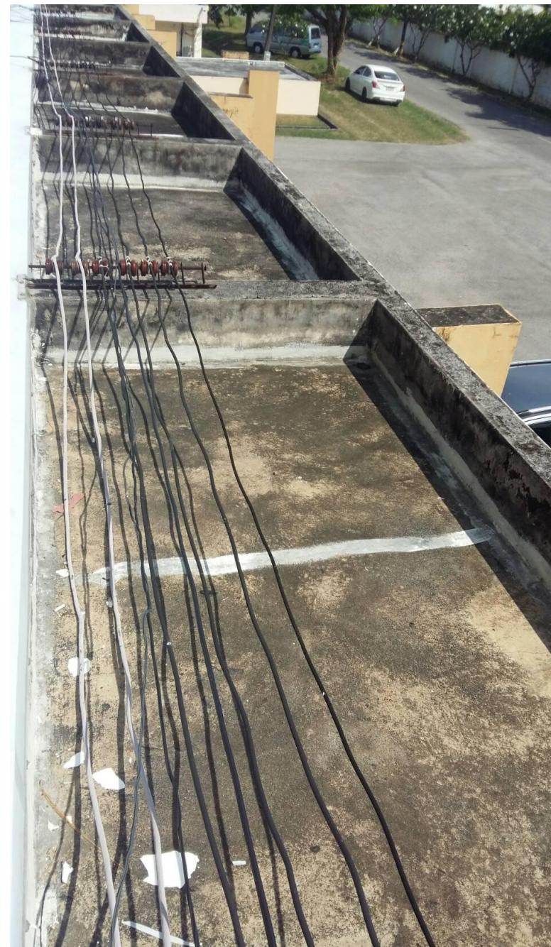
สภาพดาดฟ้าที่เป็นคอนกรีตแตกร้าว ทำให้น้ำรั่วซึมเข้าไปในเนื้อซีเมนต์ ส่งผลทำให้ เหล็กเป็นสนิมและซีเมนต์หลุดร่อน
