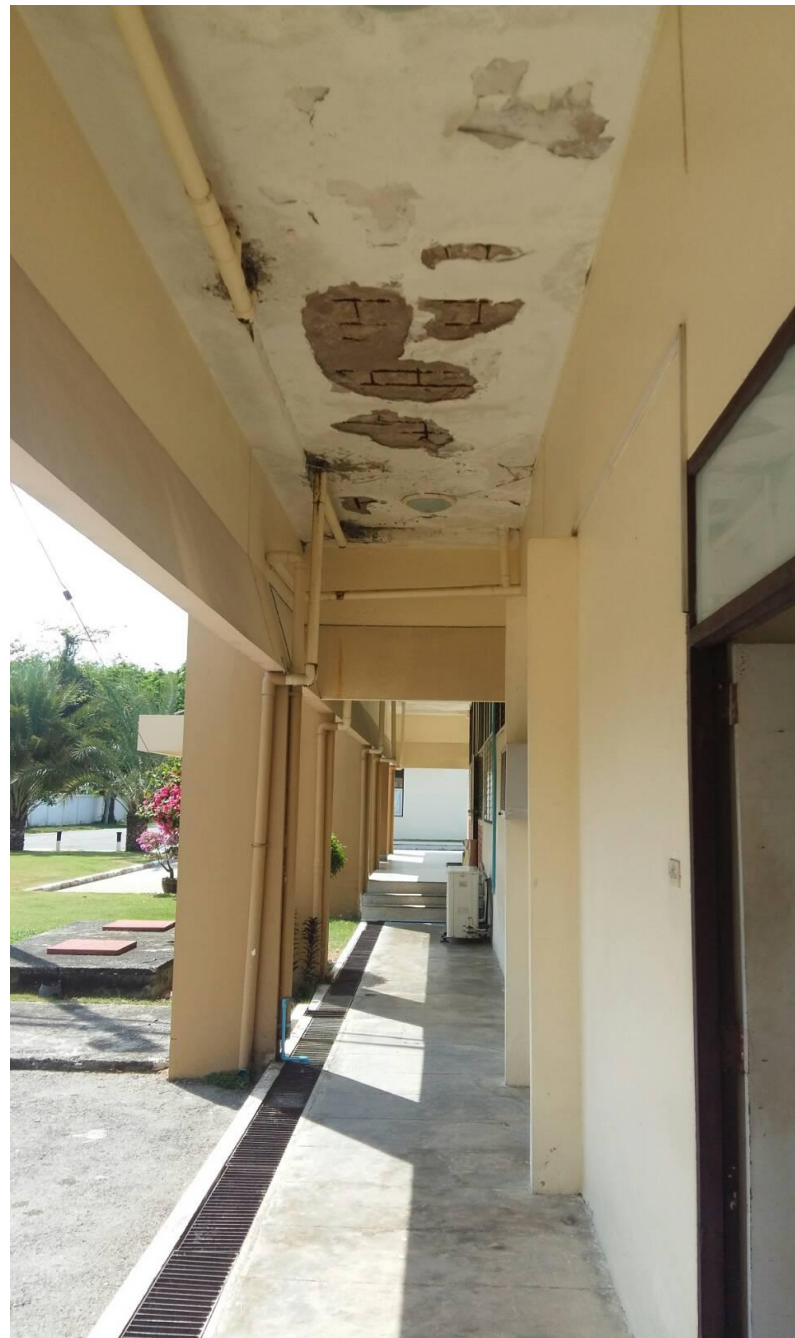
สภาพดาดฟ้าที่เป็นคอนกรีตแตกร้าว ทำให้น้ำรั่วซึมเข้าไปในเนื้อซีเมนต์ ส่งผลทำให้ เหล็กเป็นสนิมและซีเมนต์หลุดร่อน
